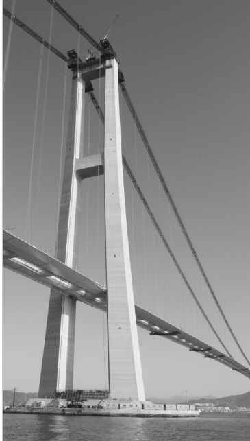
시공 중인 주탑.
